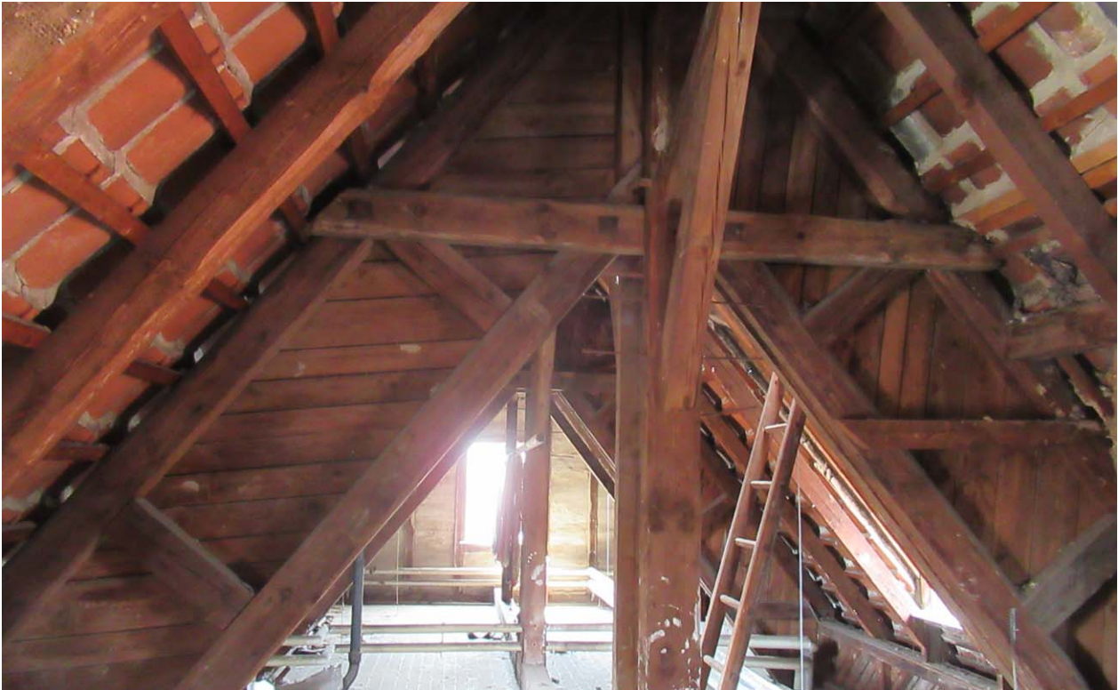
Abb. 16 Dachtragwerk im Bestand
