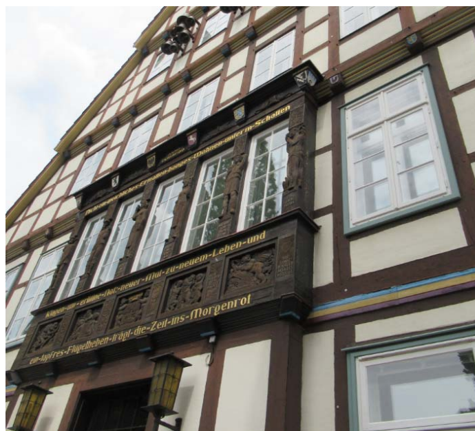
Abb. 13 Fassade an der Marktstraße im Bestand
