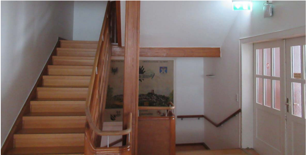
Abb. 19 Holzterpe im Bestandtreppenraum
