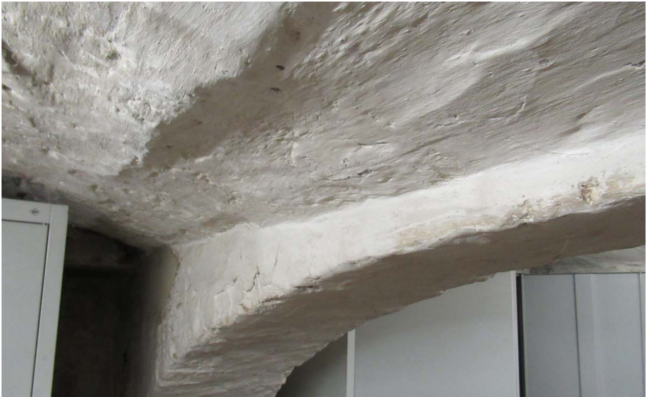
Abb. 15 Gewölbedecke im Kellergeschoss im Bestand
